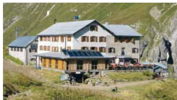
Der eindrucksvolle Bau der Kemptner Hütte bietet ein stattliches Haupthaus, Panoramastube, Anbau und Terrasse sowie Kellernutzräume und Nebengebäude.
